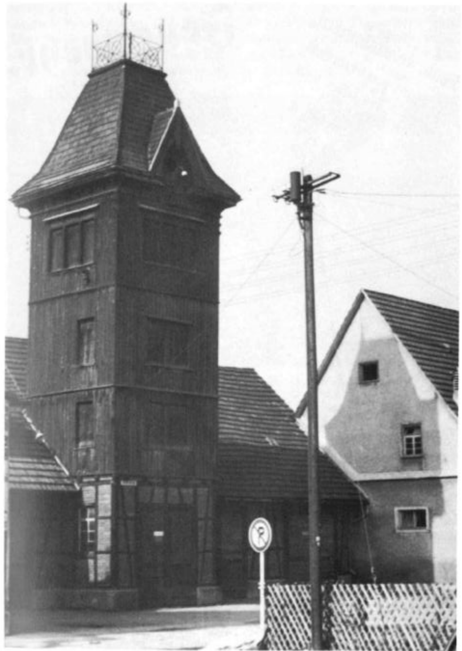
Das im Jahre 1896 bezogenen Feuerwehrgerätehaus in zentraler Lage (Heute Neuer Marktplatz)
